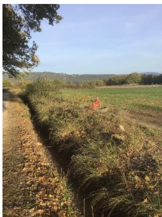
Chemin de Traspigut : canal du Verdon abandonné et borne de distribution de l'eau du canal de Provence (Photo de l'auteure)
