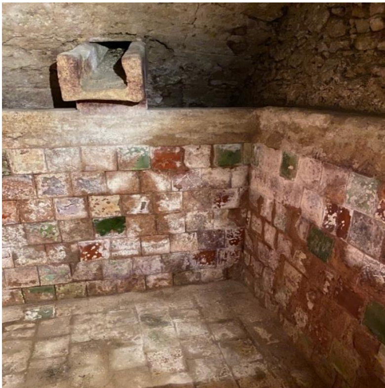
La cuve recouverte de carreaux de faïence et son canon, photo Corinne Renaux, 2022
