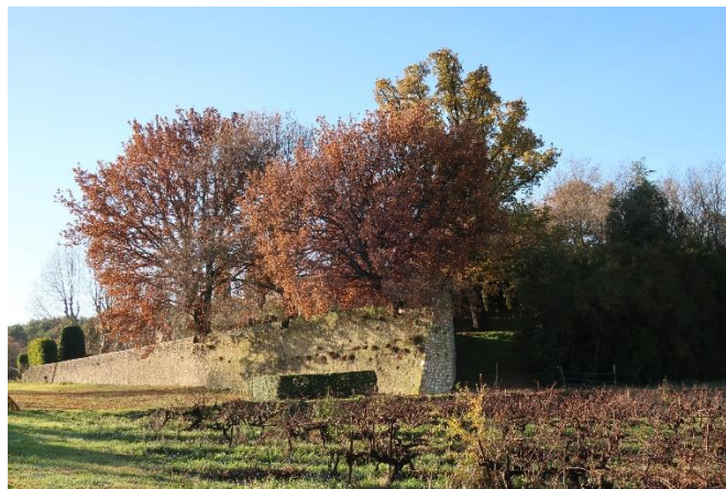
Mur d'enceinte du château, face nord (Photo de l'auteur)
