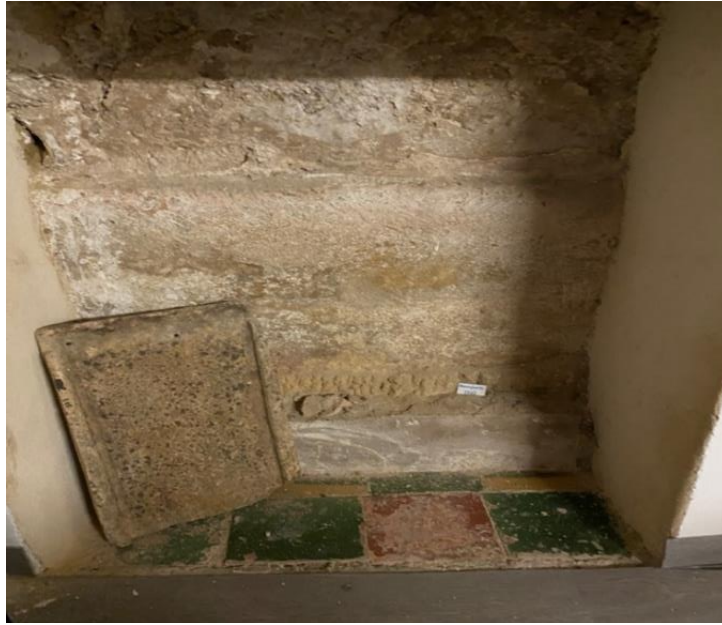
Présence sur le sol de carreaux identiques à ceux de la cuve, photo Corinne Renaux, 2022
